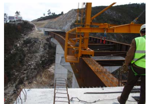
Figura 7: Ajuste altimétrico do pórtico
