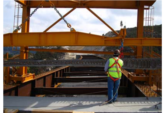
Figura 5: Deslocação do Pórtico sobre as vigas metálicas
