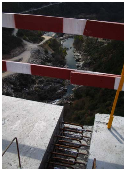
Figura 10: Guarda-corpos de protecção colectiva
