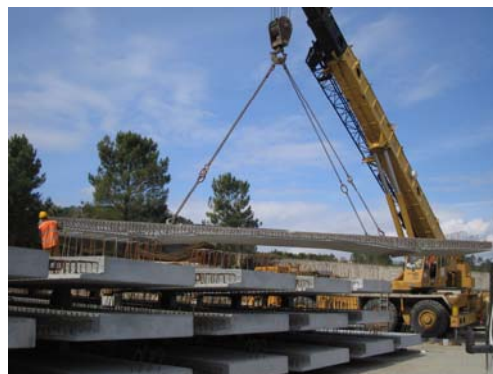
Figura 2: Aspecto geral dos segmentos de laje
