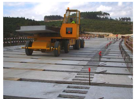
Figura 6: Deslocação do carro de transporte sobre as lajes
