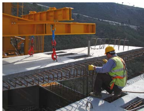
Figura 4: Montagem da laje/ conectores
