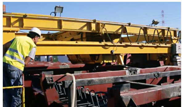
Figura 3: Pormenor do balde distribuidor de betão
