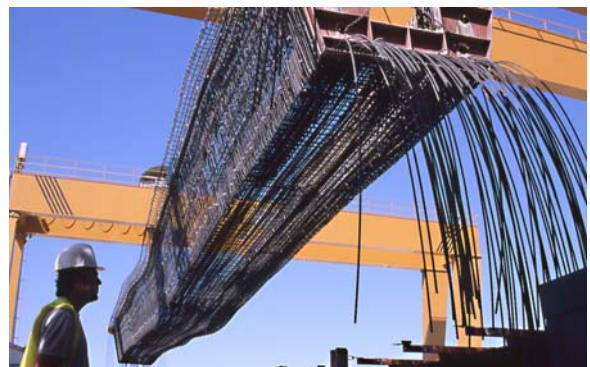
Figura 4: Vista de armadura pronta a entrar no molde
