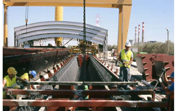
Figura 2: Cobertura móvel da pista de pré-esforço
