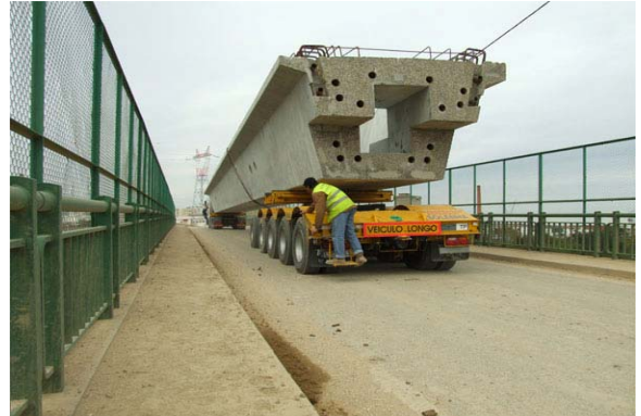
Figura 5: Transporte especial/ viga 160 ton.
