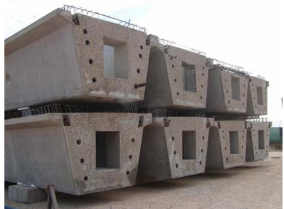
Figura7: Armazenagem de vigas em altura
