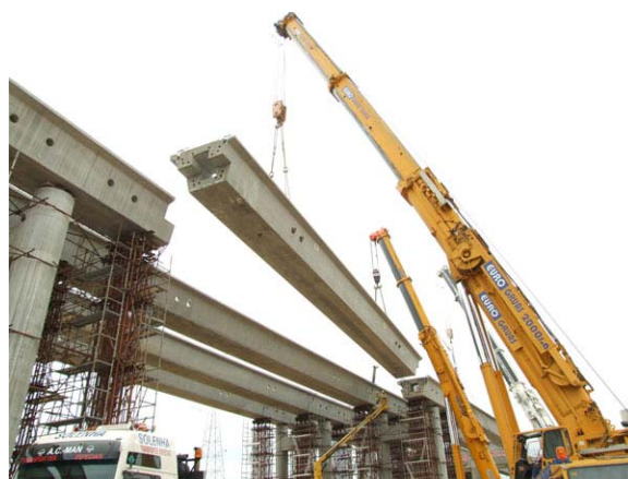
Figura 9: Sequência de montagem a 3 guas
